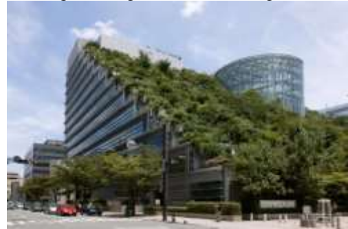
Рис.3. Здание офиса в городе Фукуока
