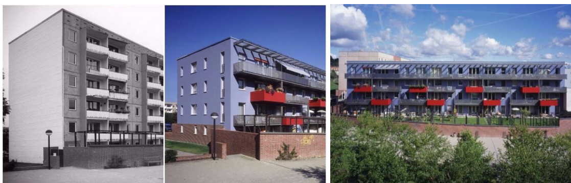
Рис. 3. Реконструкция многоэтажного дома в Германии. Город Лайнефельде.
